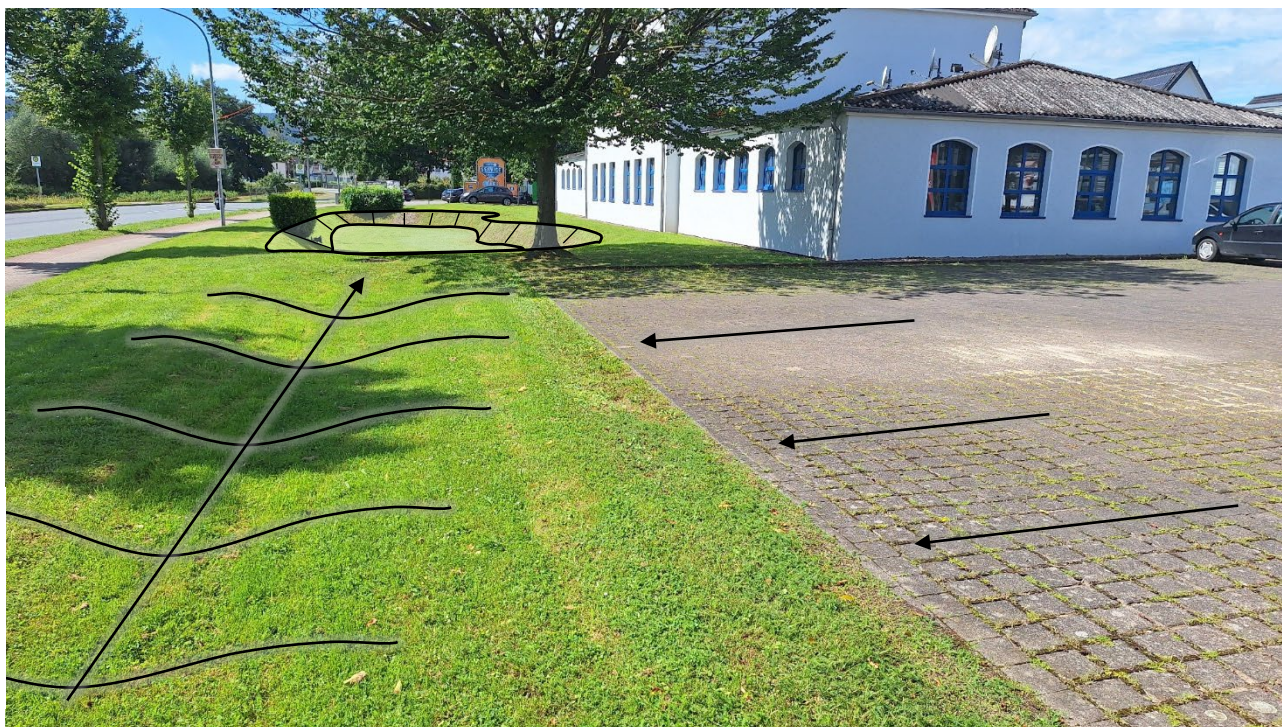
Abb. 88: Kombination aus Versickerungsmulde und angeschlossenem Retentionsbecken in Höxter: In diesem Beispiel wird überschüssiger Niederschlag von einem Parkplatz in eine Versickerungsmulde geleitet und in ein Retentionsbecken abgeführt, das über einen Überlauf mit der Kanalisation verbunden ist. Ein Netz aus solchen Systemen kann große Niederschlagsmengen versiegelter Flächen fassen. Die Bepflanzung besteht häufig aus Rasen und ist günstig und pflegeleicht, aber ökologisch wenig wertvoll.
